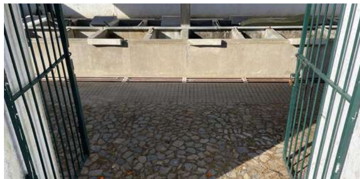
Manutenção dos Tanques
