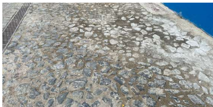
Reparações de Calçada
