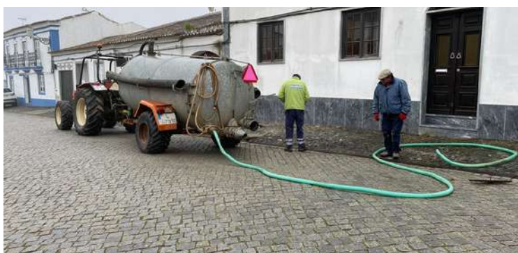
Limpeza de sarjetas e sumidouros
