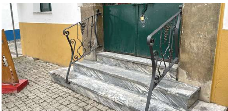
Aplicação de corrimão no Mercado Municipal
