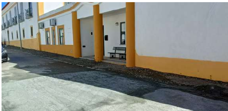
Reparações de vias públicas
