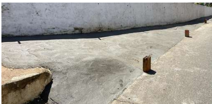
Reparação de passeios
