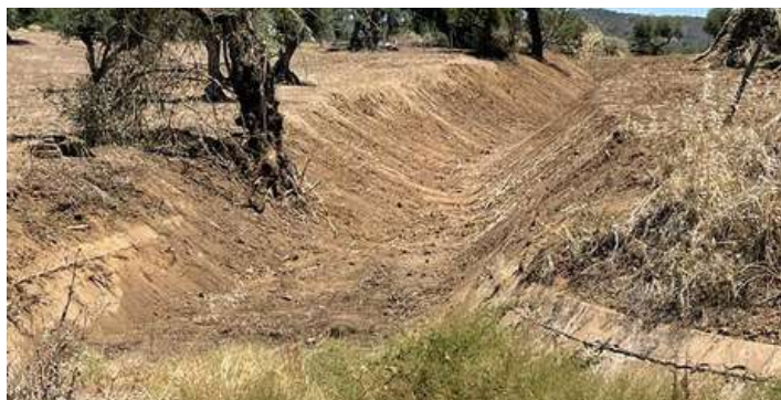
Limpeza da linha de água do Almargem
