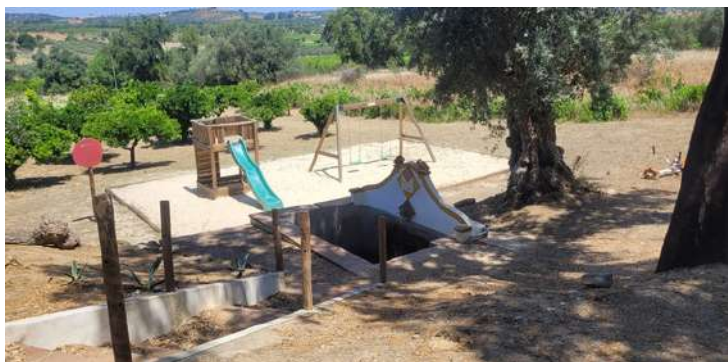
Manutenção da Fonte do Ripado
