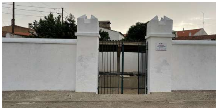
Manutenção dos Tanques
