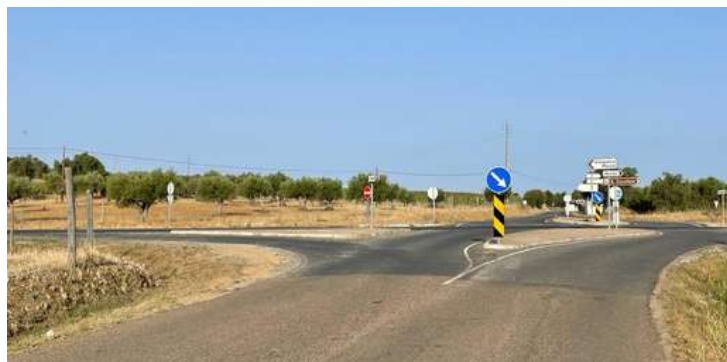
Limpeza e manutenção dos cruzamentos
