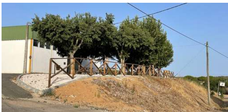
Limpeza de barreiras
