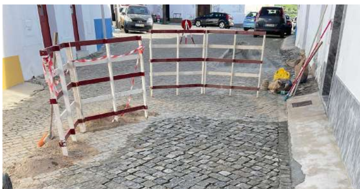
Reparação de calçadas e passeios
