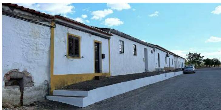
Pintura de muros
