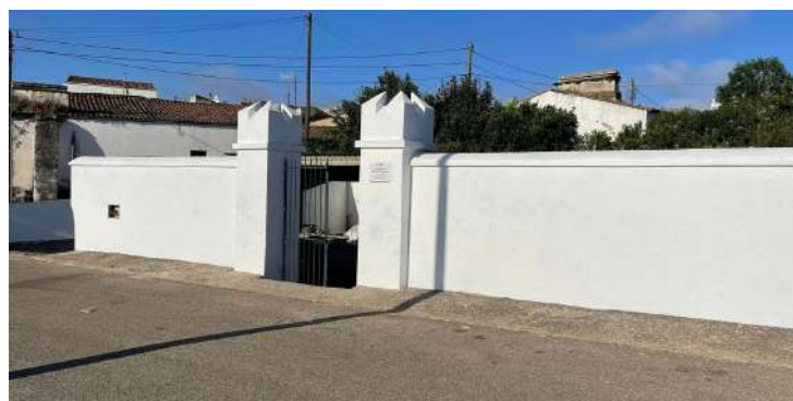
Manutenção dos Tanques
