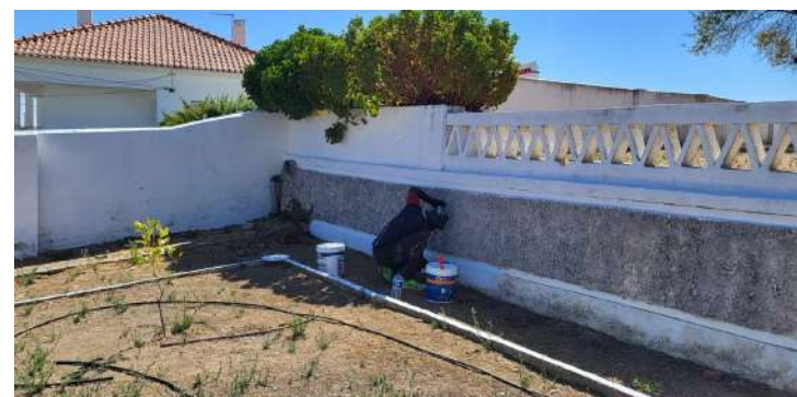
Pintura dos Muros da Escola
