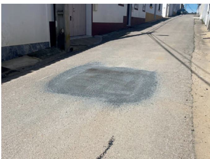
Reparação de vias e ramais
