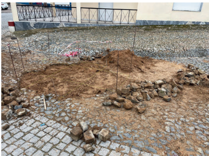
Reparação de Calçadas
