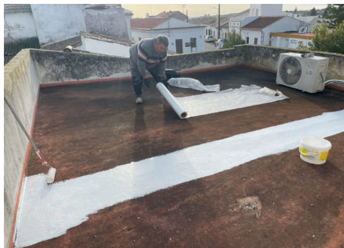
Manutenção do Centro de Dia
