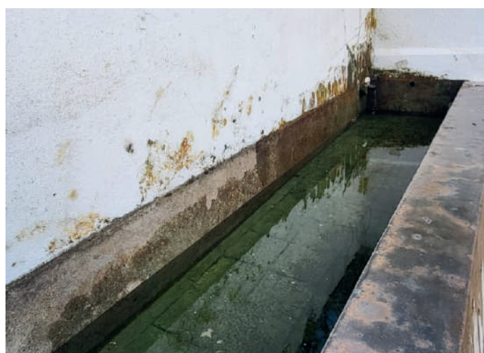
Limpeza de Tanques
