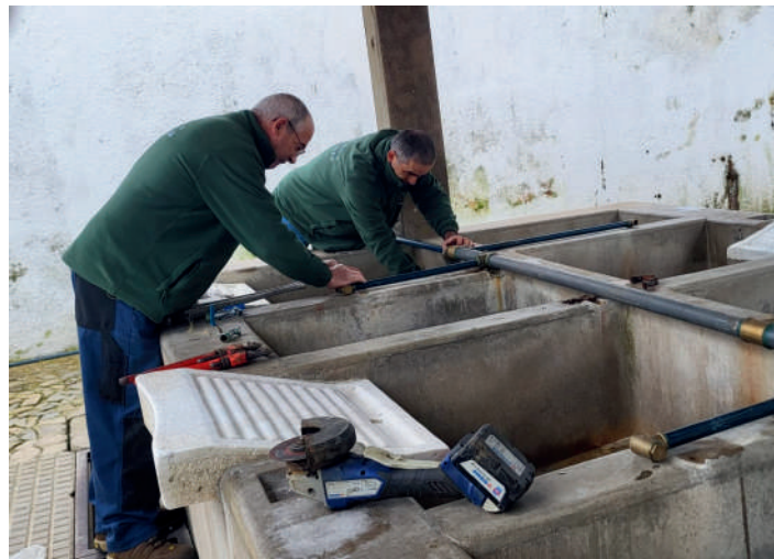
Manutenção dos Tanques de Lavagem
