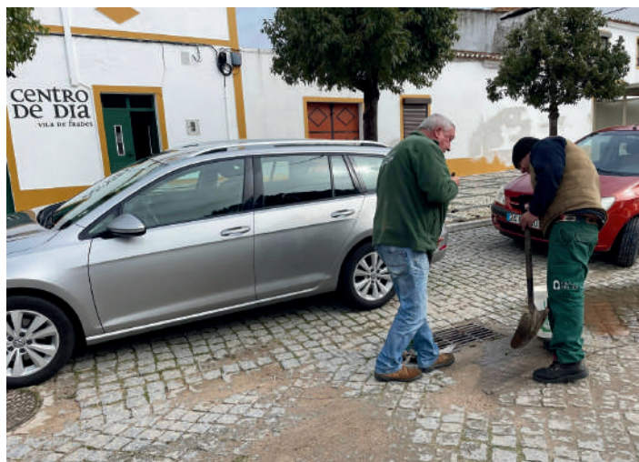
Limpeza de sarjetas e sumidouros
