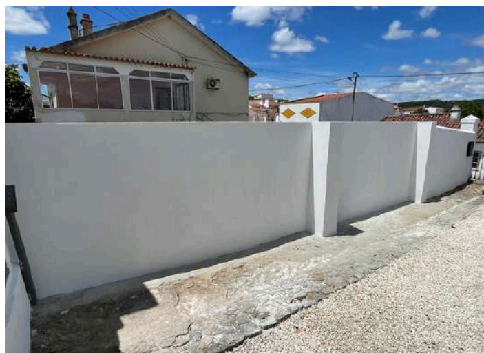
Reconstrução do muro da escola
