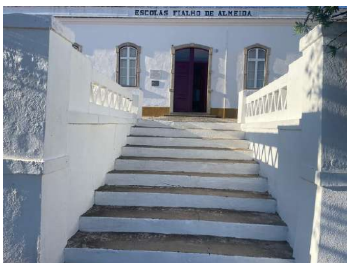
Limpeza e pinturas na Escola
