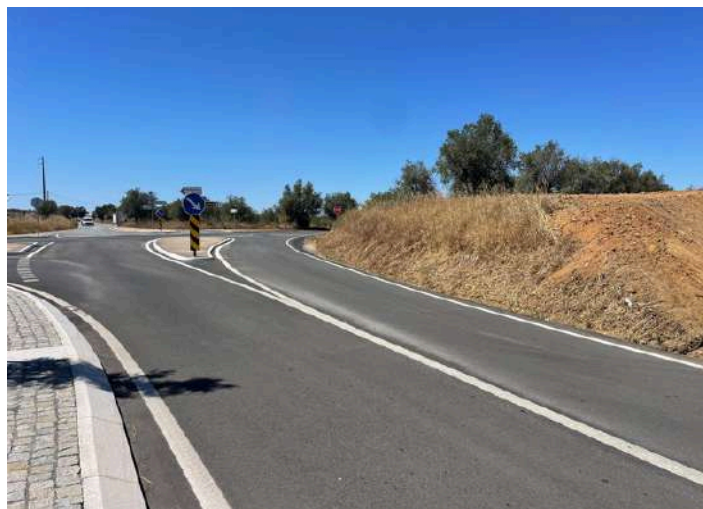
Limpeza de bermas
