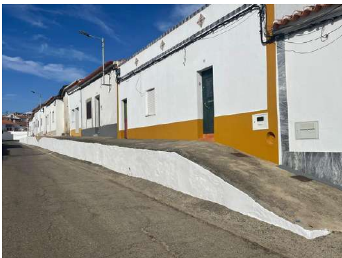
Pintura dos muros e balcões
