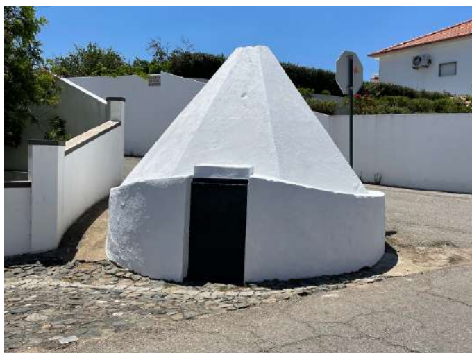
Pintura do Poço Pedreiro
