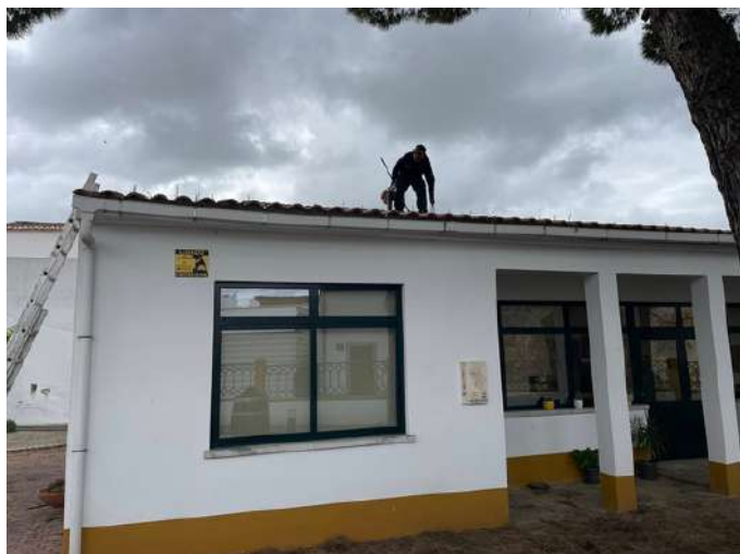
Manutenção da sede da junta
